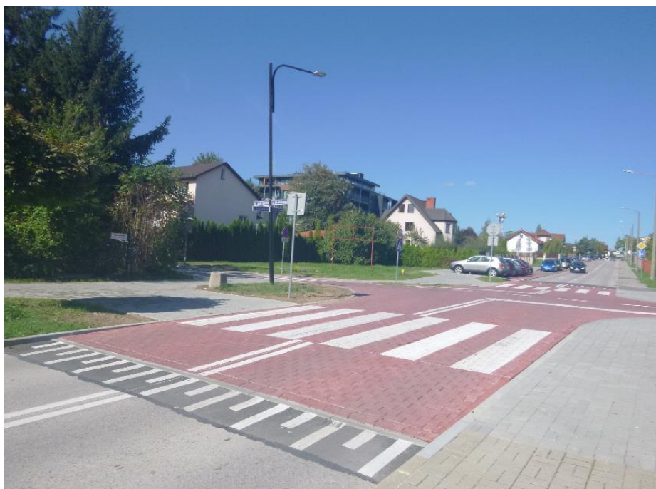
Fotografia 15 -Przebudowa skrzyżowań na terenie miasta, celem poprawy płynności ruchu komunikacyjnego – skrzyżowanie Bohaterów Westerplatte z ul. Armii Krajowej - po realizacji
