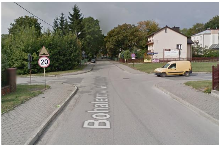
Fotografia 14 -Przebudowa skrzyżowań na terenie miasta, celem poprawy płynności ruchu komunikacyjnego – skrzyżowanie Boh. Westerplatte z ul. Armii Krajowej - przed realizacją
