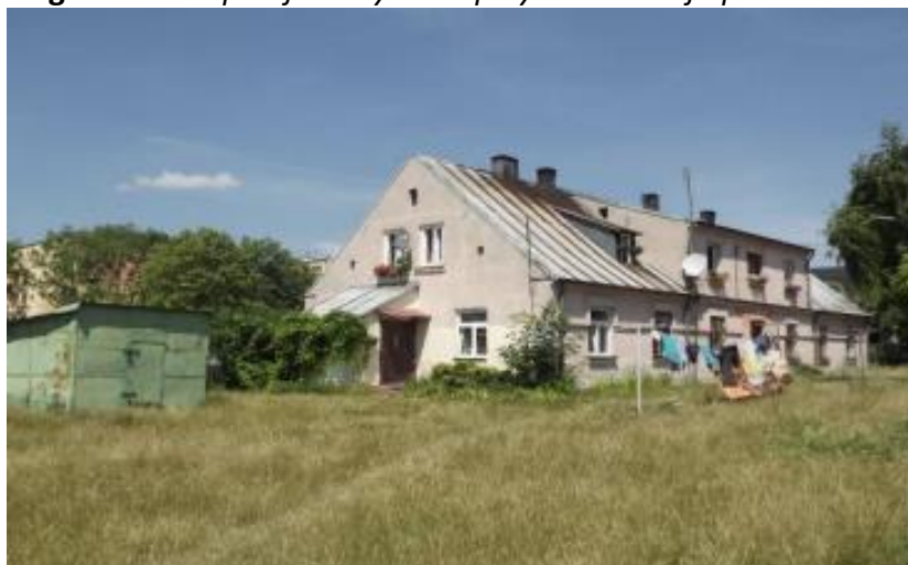
Fotografia 8 Adaptacja budynków przy ul. Bocznej– przed realizacją
