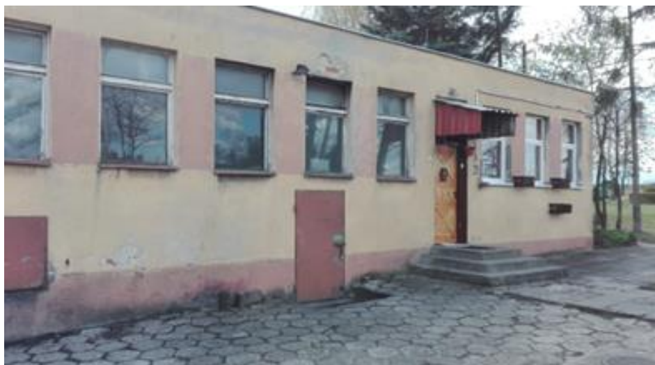
Fotografia 23- Termomodernizacja budynku z mieszkaniami w miejscowości Młyny – przed realizacją
