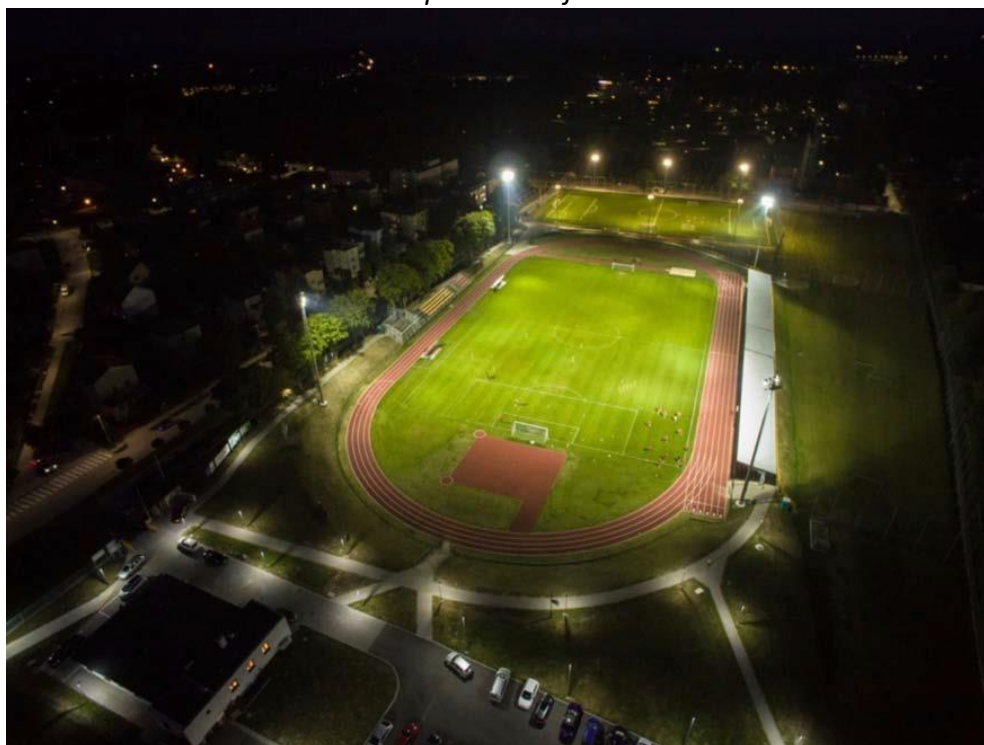
Fotografia 39 - Stadion sportowy przy ul. Kusocińskiego - oświetlenie płyty głównej boiska – po realizacji
