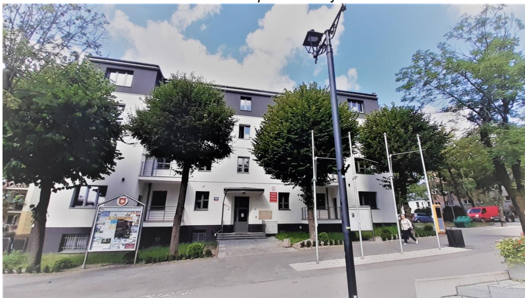
Fotografia 19- Termomodernizację budynku Urzędu wraz z remontem części wewnętrznej obiektu – po realizacji
