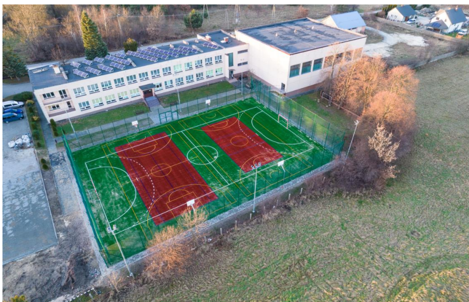
Fotografia 38 - Budowa boisk wielofunkcyjnych przy Szkołach Podstawowych w gminie Busko-Zdrój- boisko wielofunkcyjne w Kołaczkowicach – po realizacji.
