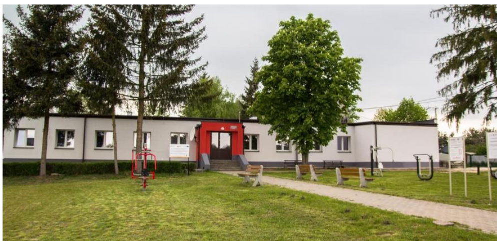
Fotografia 24 - Termomodernizacja budynku z mieszkaniami w miejscowości Młyny – po realizacji
