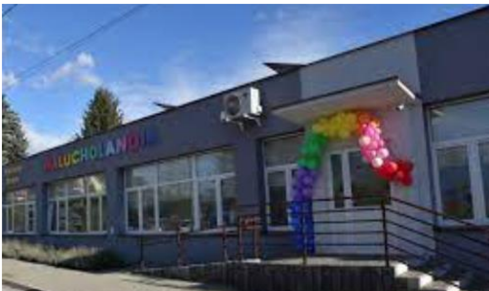
Fotografia 31- Rozwój infrastruktury opieki żłobkowej- po realizacji
