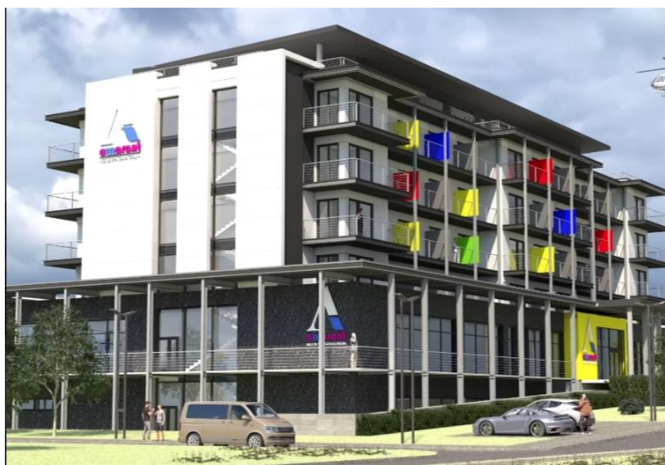
Fotografia 40 - Sanatorium Uzdrawiskowe Amarant w Busku-Zdroju – po realizacji
