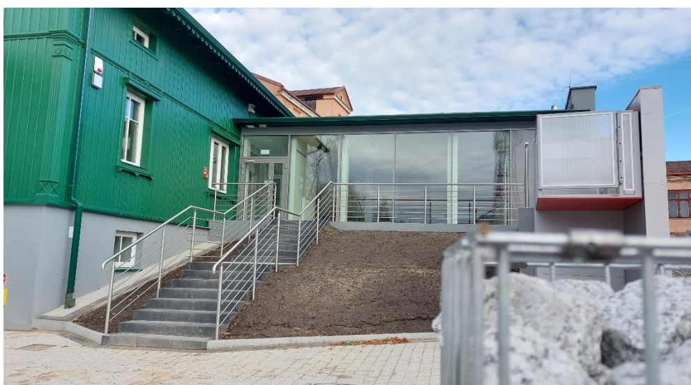
Fotografia 4 Galeria Sztuki „Zielona” - po realizacji
