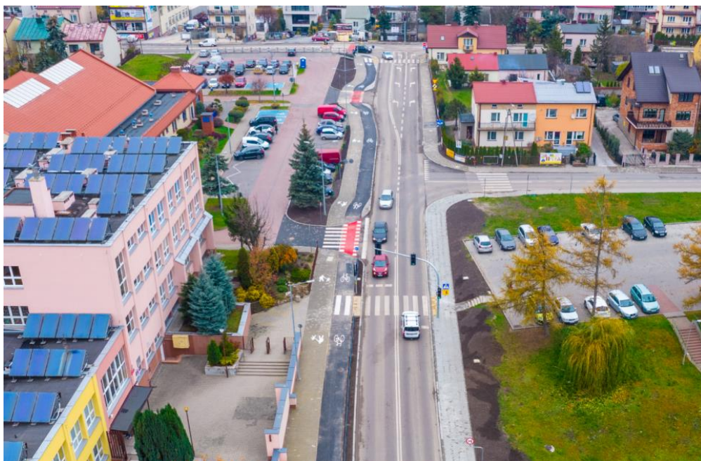
Fotografia 17 -Przebudowa skrzyżowania ul. Grotta nr 314148T z ulicami Partyzantów, Batorego- po realizacji
