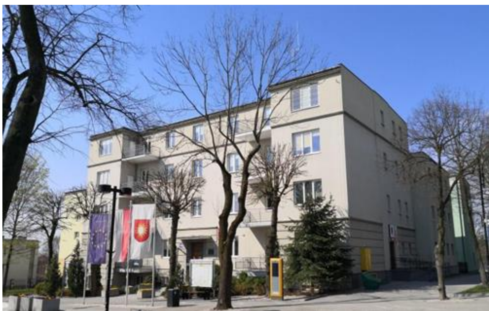
Fotografia 18- Termomodernizację budynku Urzędu wraz z remontem części wewnętrznej obiektu – przed realizacją
