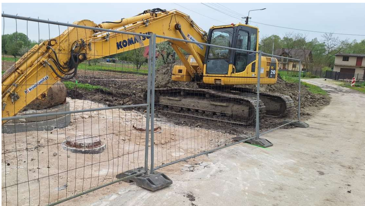
Zdjęcie 2. Prace związane z rozbudową kanalizacji sanitarnej w Gminie Busko-Zdrój – etap I.
