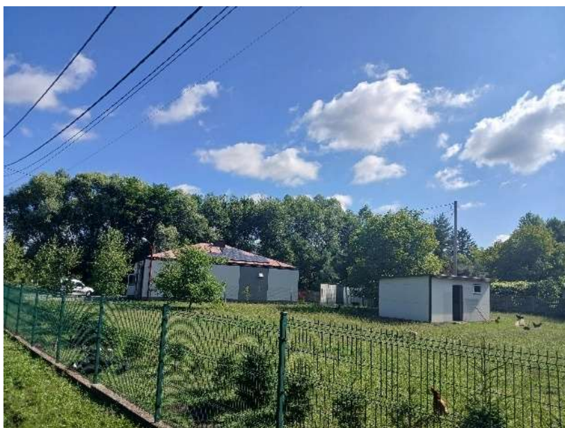
Zdjęcie 8. Świetlica wiejska i strażnica OSP w Skotnikach Małych.
