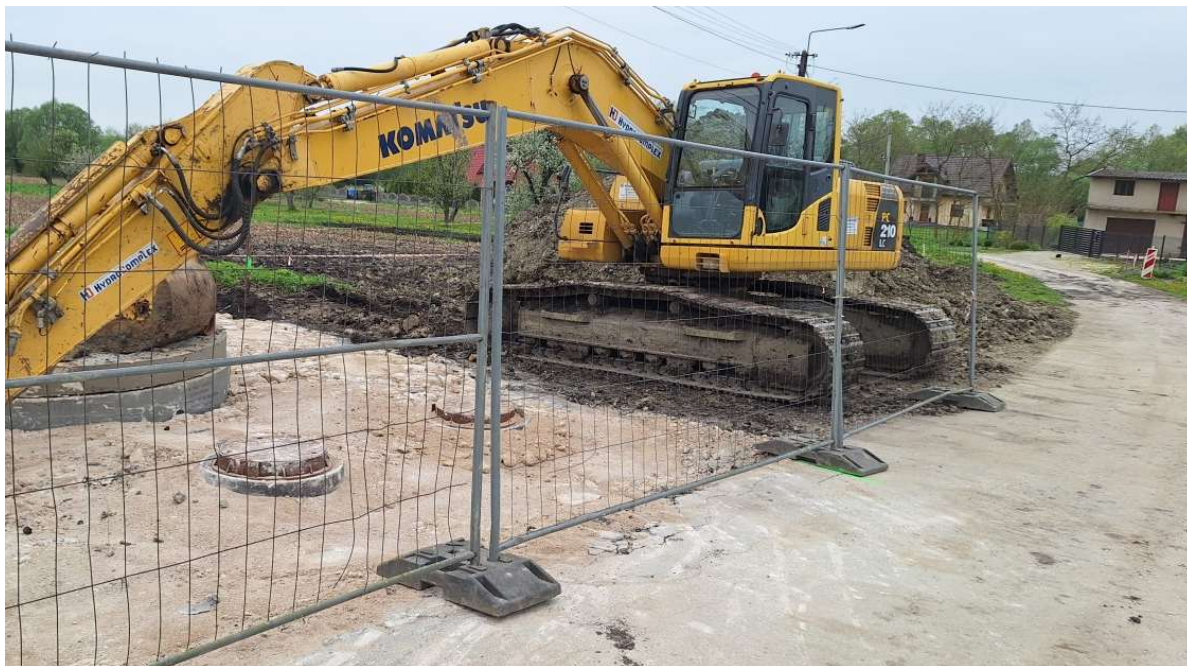
Zdjęcie 2. Prace związane z rozbudową kanalizacji sanitarnej w Gminie Busko-Zdrój – etap I.
