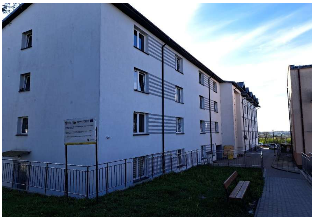
Zdjęcie 6. Budynek wielorodzinny przy ul. Boh. Warszawy w Busku-Zdroju.
